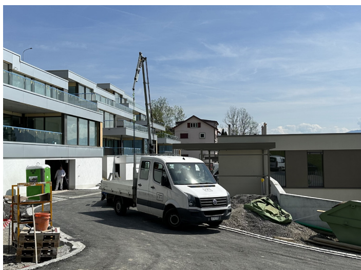
Mehrere Gewerke arbeiten Hand in Hand.
