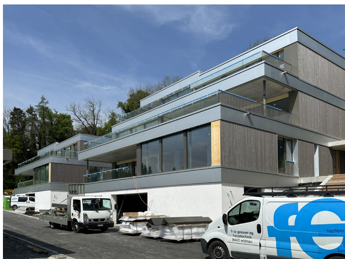
Letzte Bauteile für die Fassaden werden montiert.
